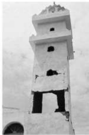
Figure 4.2 Changement brusque des rigidités en élévation
