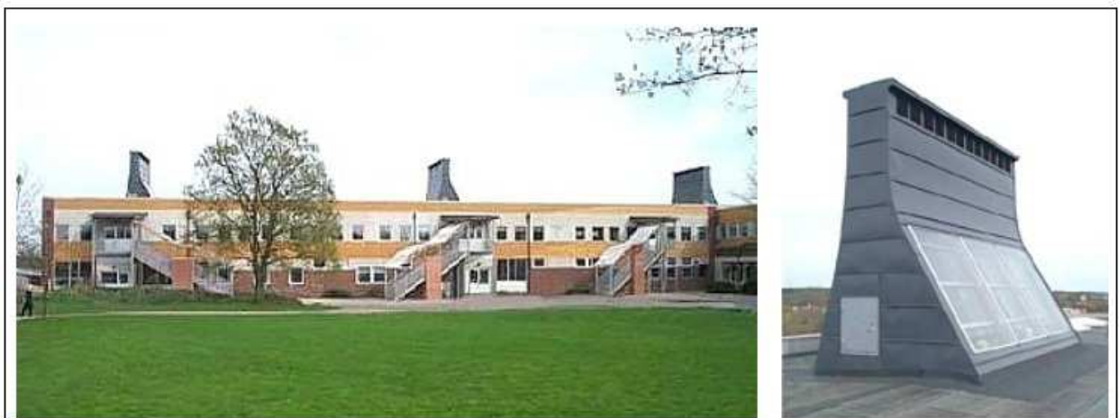
Fig.(I.13): Présentation d'une cheminée solaire à l'école Tanga (Suède) [44].
