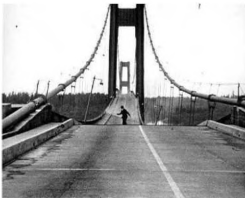
Figure 1-2 : Effondrement du pont de Tacoma sous l'action du vent en 1940
