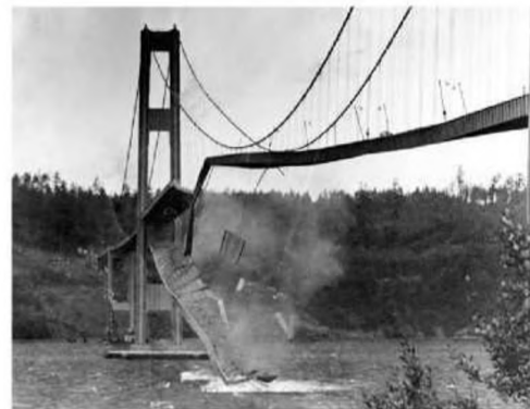
Figure 1-2 : Effondrement du pont de Tacoma sous l'action du vent en 1940
