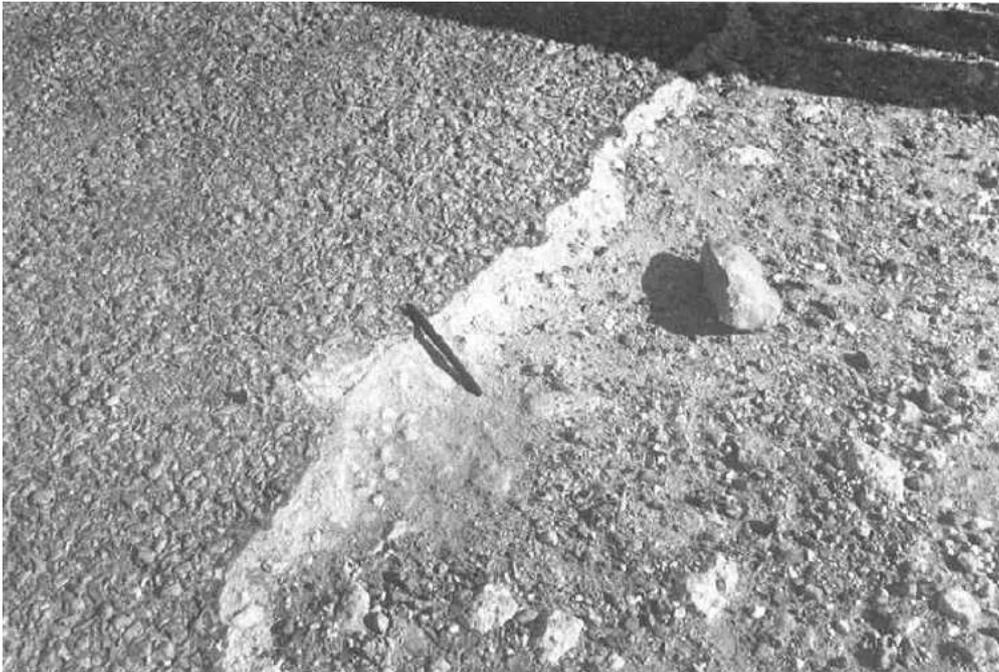
*Photo III-3 : Constatation sur le bord de la chaussée, en enlevant la couche d'enduit, que la couche de tuf est devenue très dur en surface (route Gallela-sedouikech en Tunisie).*
