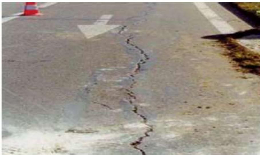
*Figure II-1 : Fissuration longitudinale dans une chaussée, attribuée aux effets des cycles d'humidification séchage dans le talus (Ferber et al. 2009 cité par Goual, 2012).*
