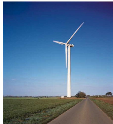
Aérogénérateur à axe horizontal
