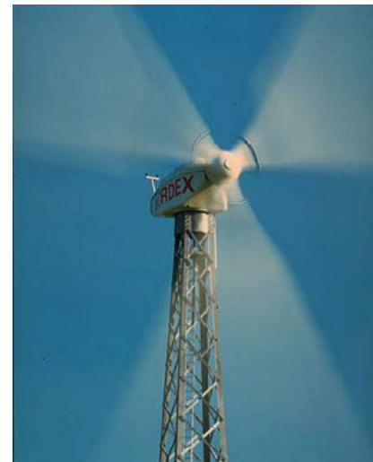
Fig. I.14. Pylône en treillis [28].
