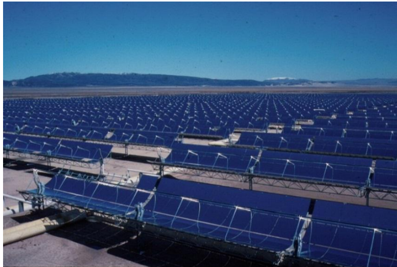
Figure 1.4. Vue montrant une partie de la centrale SEGS en Californie [8].
