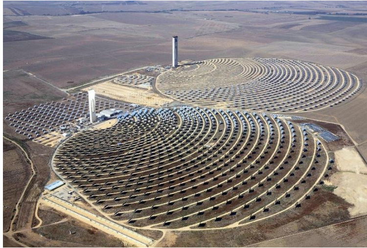
Figure 1.6. La centrale solaire PS10 au premier plan et la centrale solaire PS20 à l'arrière-plan [18].
