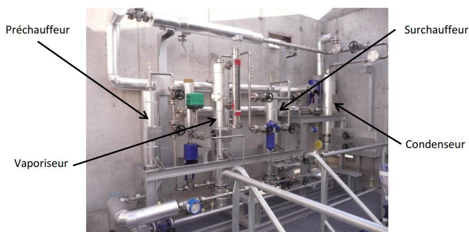
Figure 4.13. Illustration de la boucle eau/vapeur de la MicroSol-R.
