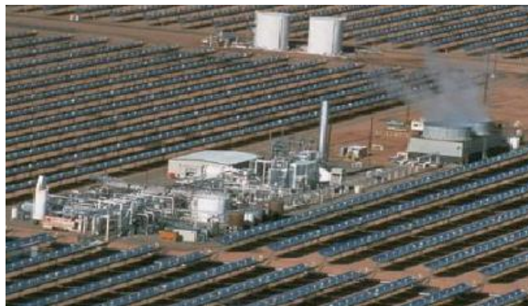
Figure 1.5. Bloc de puissance d'une centrale SEGS [8].
