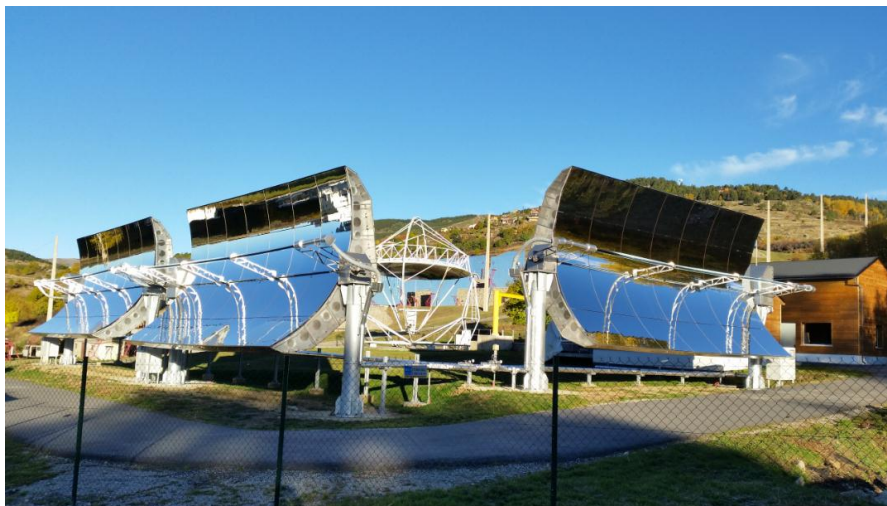
Figure 4.3. Les trois modules concentrateurs cylindro-paraboliques de la MicroSol-R.
