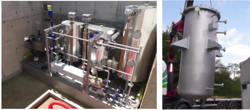
(a) Stockage à deux cuves (froide et chaude)
