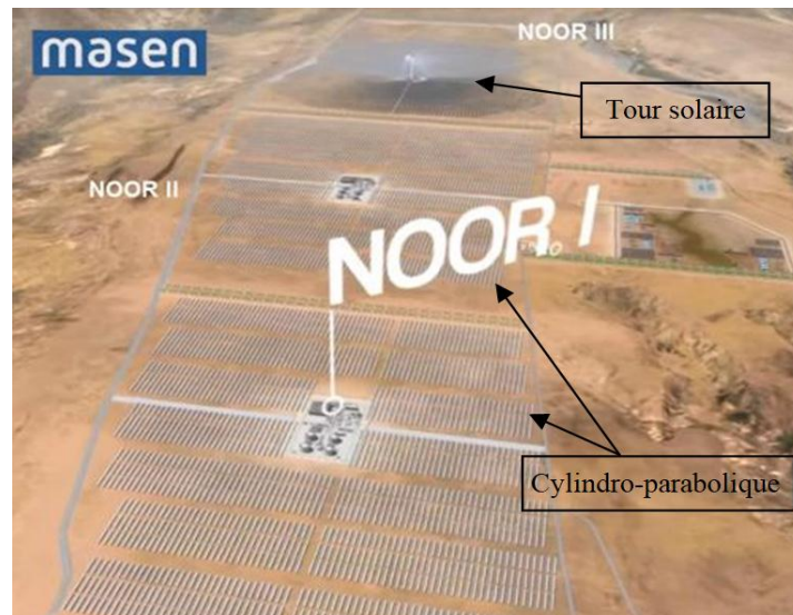
Figure 1.8. Complexe multi technologiques de 'Ouarzazate', Maroc [20].
