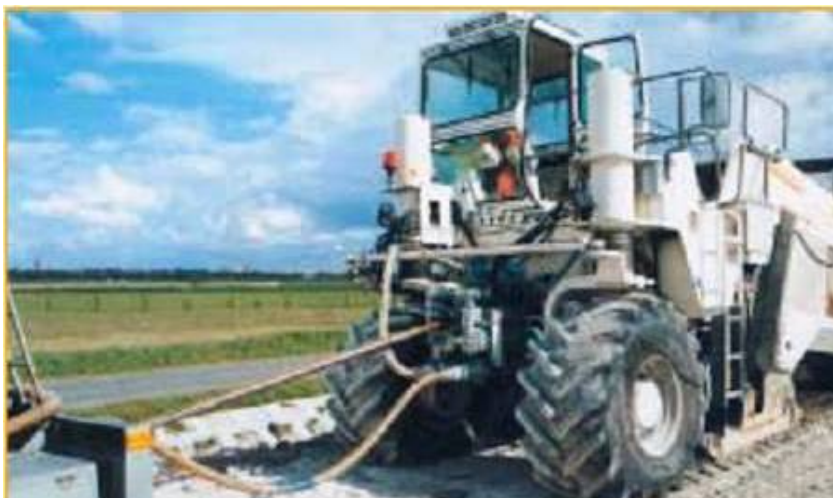
Figure 2.4 : Incorporation de ciment (site web www.loisyloc.com )
