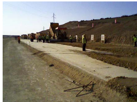
Figure 3.11 Planche d'essai en tuf traité préparé en centrale (l'Autoroute Est-ouest, tronçon Oued Tlelat - Sig)
