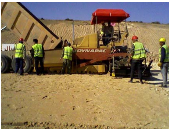
Figure 3.11 Planche d'essai en tuf traité préparé en centrale (l'Autoroute Est-ouest, tronçon Oued Tlelat - Sig)
