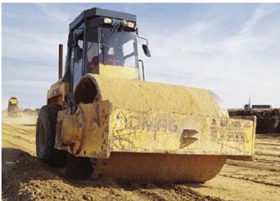
Figure 3.13 Compactage par l'utilisation de rouleaux vibrants à pieds
