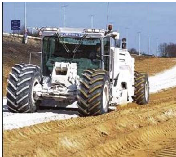
Figure 2.1 : Route en cours de stabilisation
