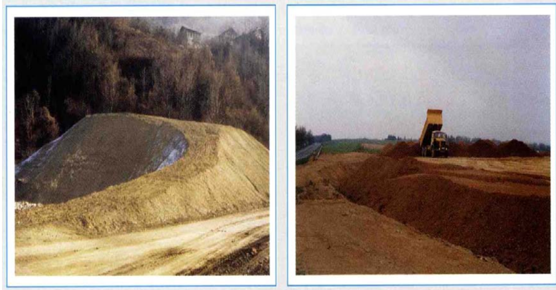
Figure 3.6 Homogénéisation par constitution de dépôts provisoires
