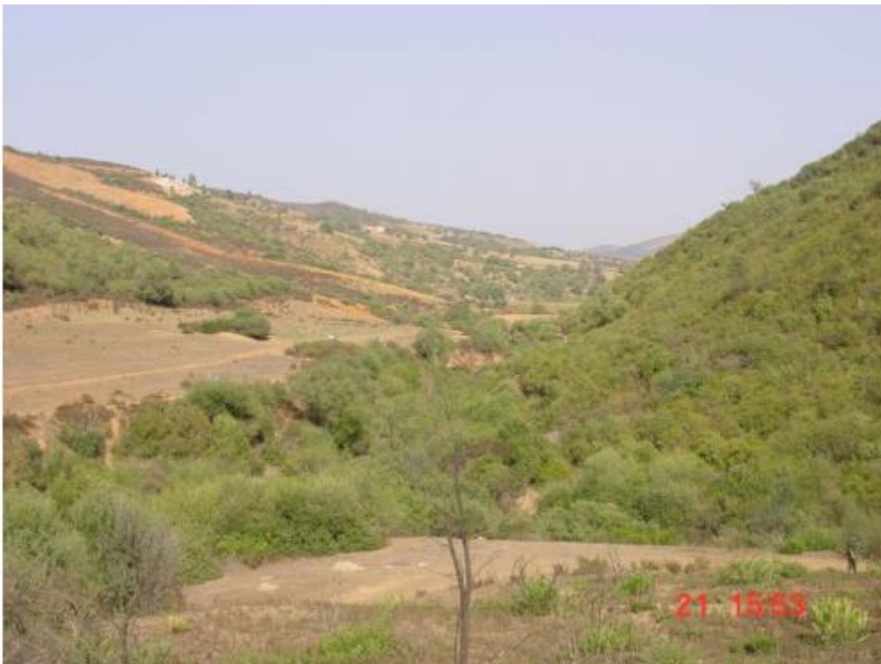
Photo II-4 : Axe de la digue principale (flanc droit)
