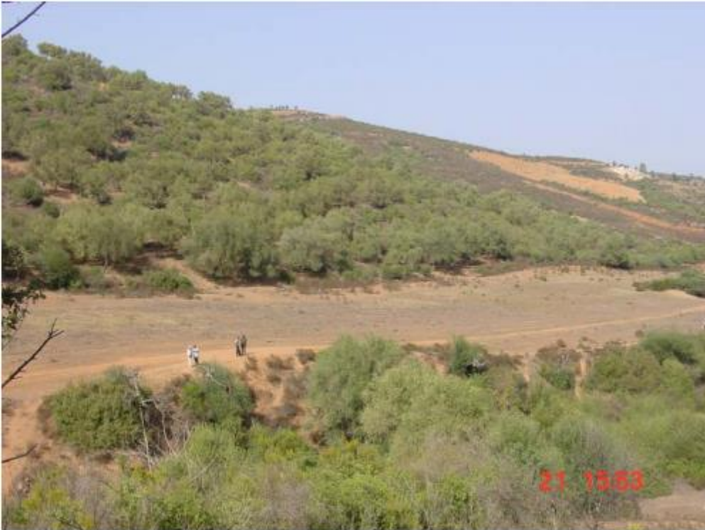
Photo II-3 : Axe de la digue principale (flanc gauche)
