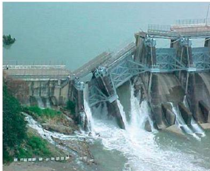
Fig.II.11 : Rupture du barrage ShiKang. [RAP]
