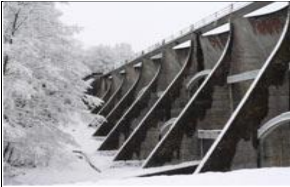
Fig.I.6 : Barrage de Grandval.[SIT]
