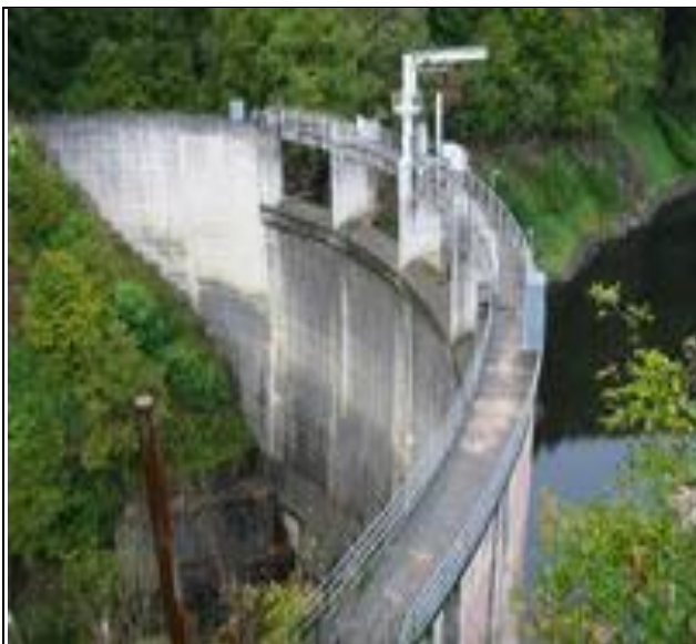
Fig.I.4 : Barrage de Luzège.[SIT]
