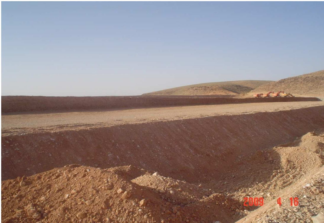
Photo II-3 : la fondation du barrage.
