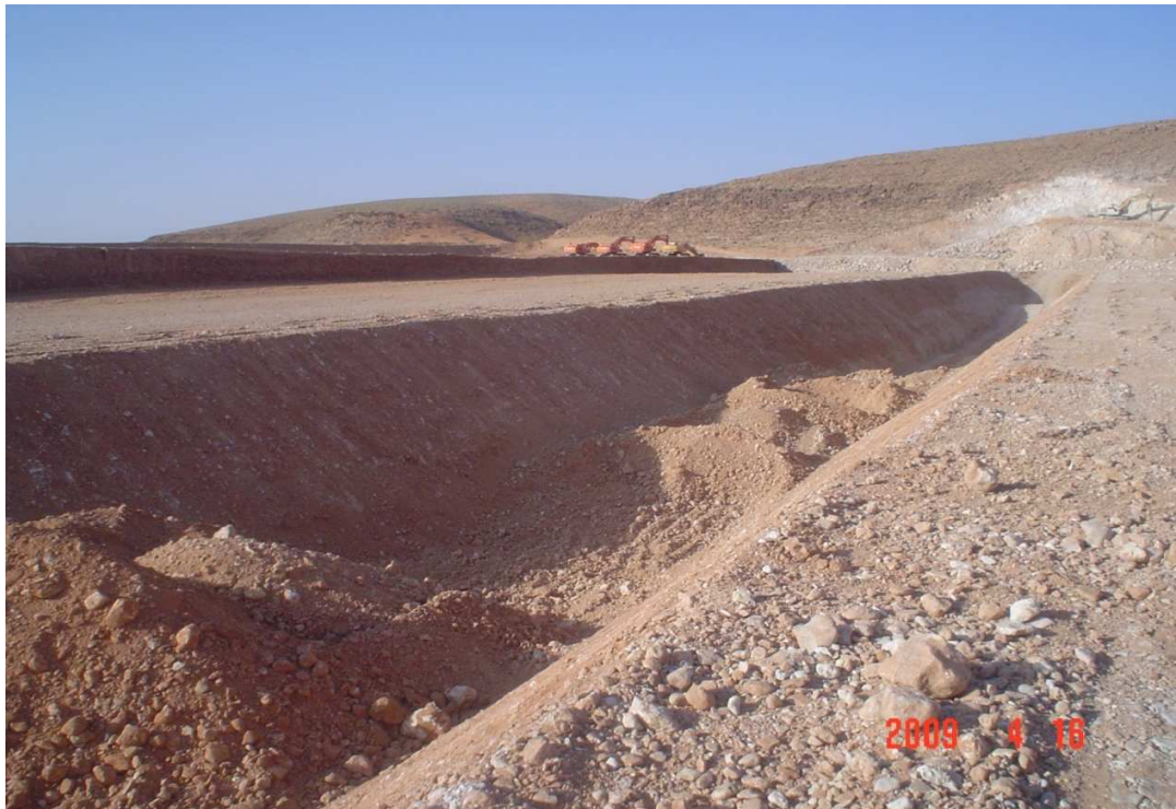
Photo II-2 : la fondation du barrage.
