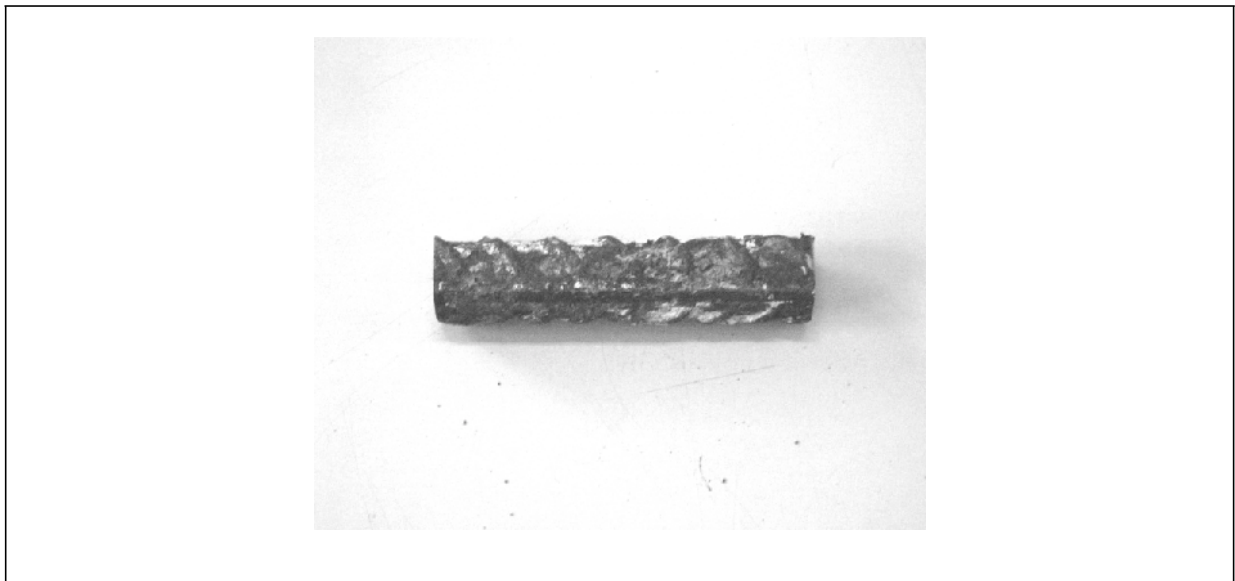
Annexe 5 : Photographie d'une zone d'armature corrodée uniformément [50]
