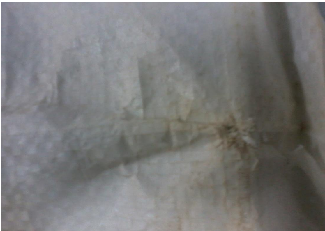
Figure V. 3 : Formation de fissurations et craquelures sur les sacs à 1% d'additif pro-oxydant après exposition naturelle pendant 91 jours.
