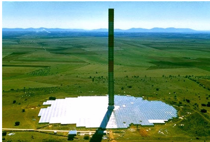
Figure 2.8: Centrale à effet de cheminée
