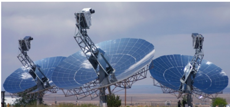
Figure 2.9: Centrale aux concentrateurs paraboliques
