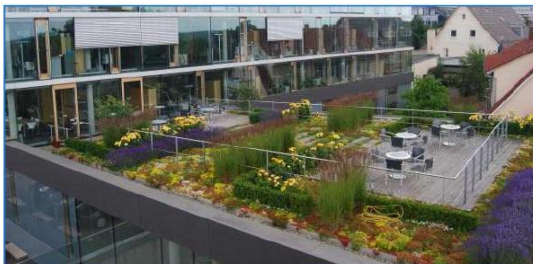
Figure IV. 7 : toiture végétalisée [Lutz, 2010]
