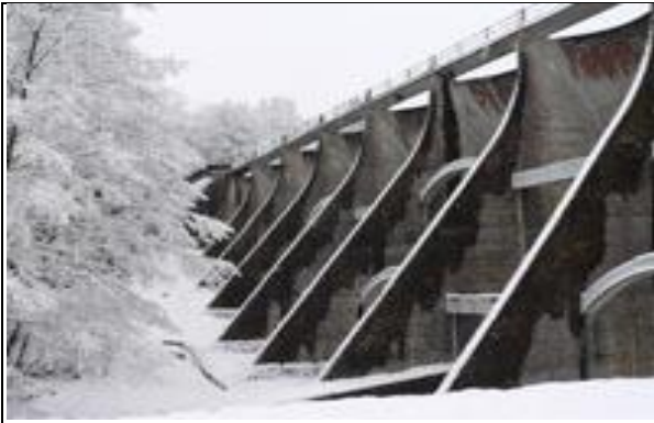
Fig.I.6 : Barrage de Grandval.[SIT]
