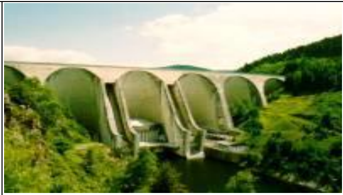
Fig.I.7 : Barrage de Faux-la-Montagne.[SIT]
