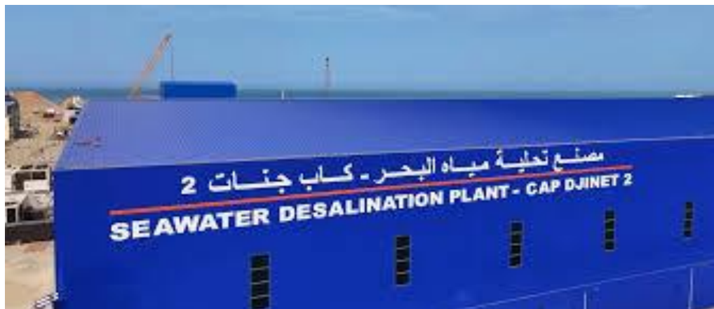
Figure II.1 : La station de dessalement d'eau de mer de Cap Djinet 2.
