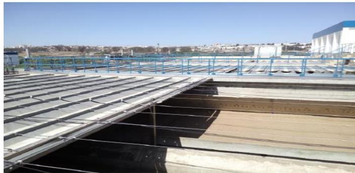
Figure 1-11: Lit de sable (filtration par filtres Aquazur V) [9]
