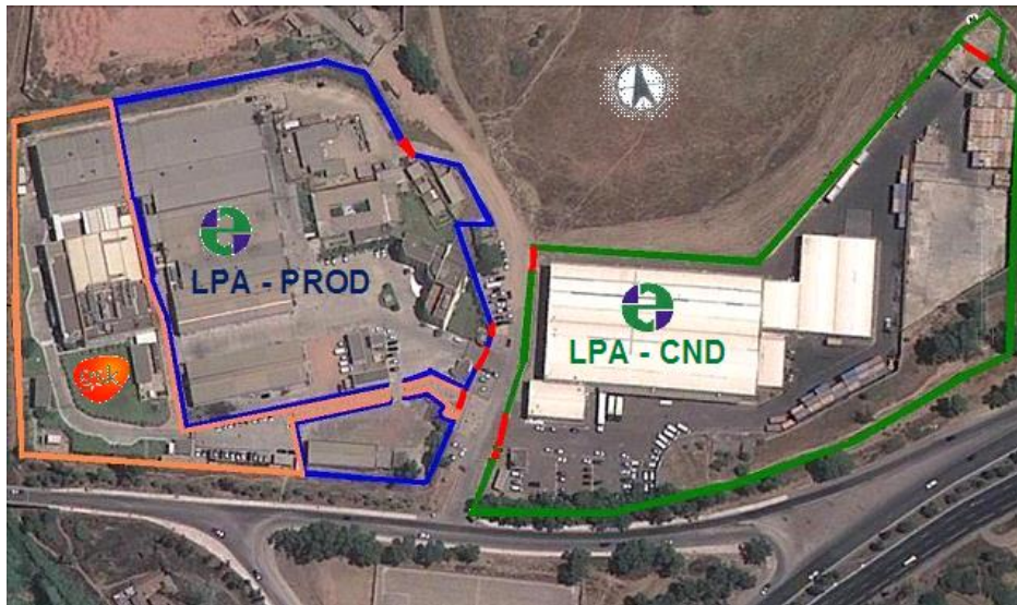
Figure I 2 : Vue aérienne du site GSK - Boudouaou
