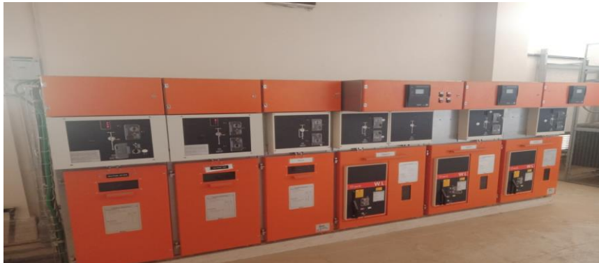
Figure 5.1 Les cellules MT au niveau de l'ASAL
