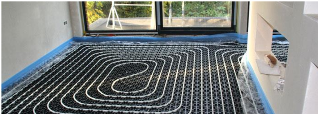
Figure 1.4: réseau de tubes d'un plancher chauffant hydraulique.
