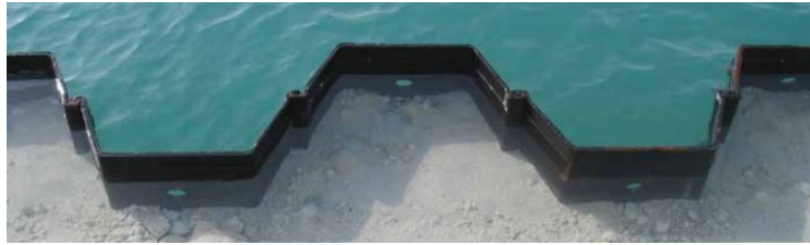
Figure I.11 : Rideau de palplanches
