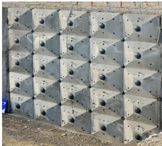
Figure I.12 : Paroi clouées
