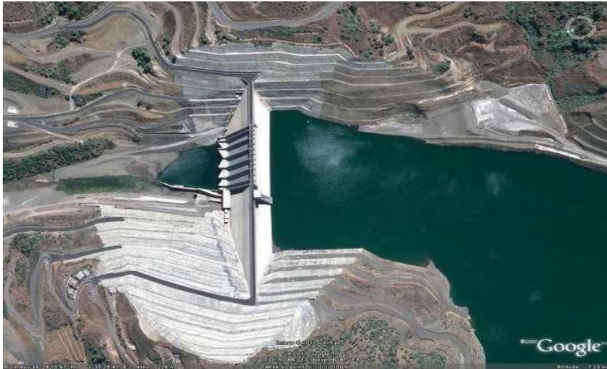
Figure 3.2 : Barrage de Koudiat Acerdoune (Google Earth, s. d.)
