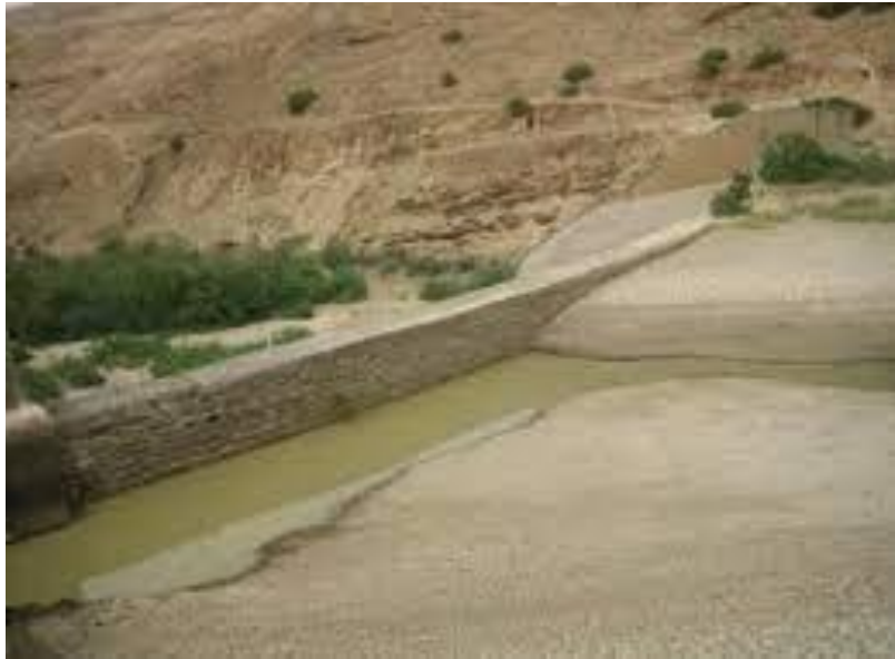
Figure 1.3 ENVASEMENT DES BARRAGES
