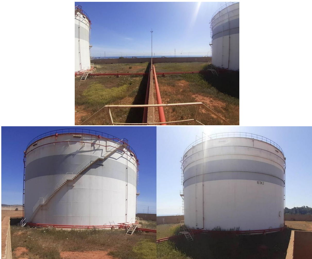
Figure III.1 : les bacs 16 TK1 et TK2
