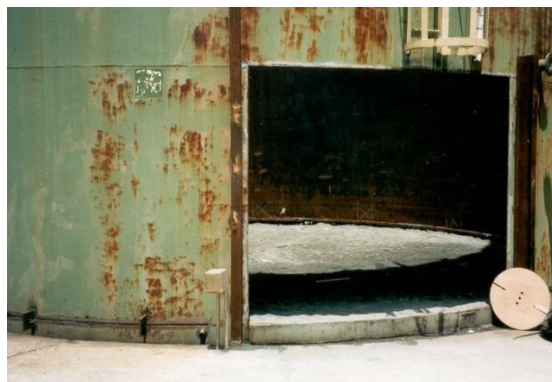
Figure V.7 : Ouverture dans les viroles pour faciliter l'accès aux travaux [12]
