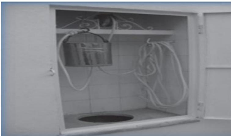
FIG. 1.4 : Dispositif de puisage de l'eau de pluie collectée dans un MAJEL dans une villa(Texas Water Development Board, 2005)
