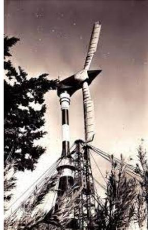
Figure 1.5 – Éolienne de 100kW des grands vents (1957) [11]
