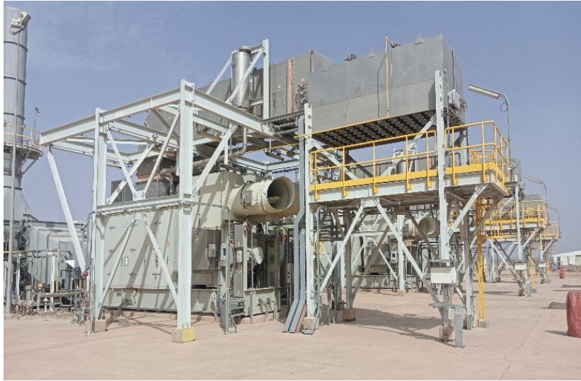
FIGURE III.4 — Gaz turbo-générateur (GTG)
