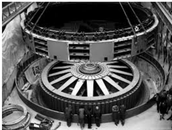
FIG. 2.7 : Photo du rotor de ce générateur
