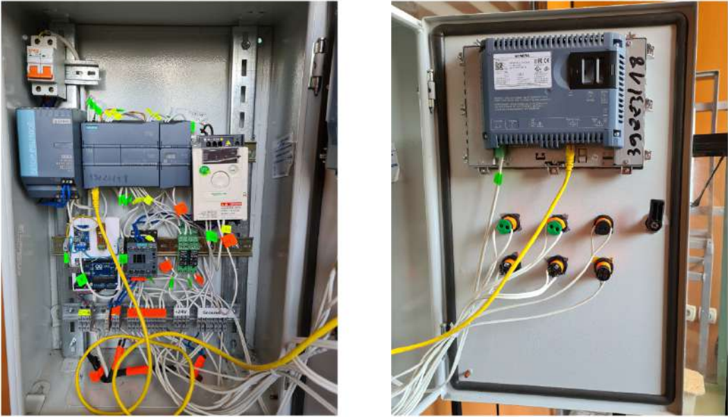
FIGURE 1.28 – Câblage de la station de pompage S7 1200 [4]
