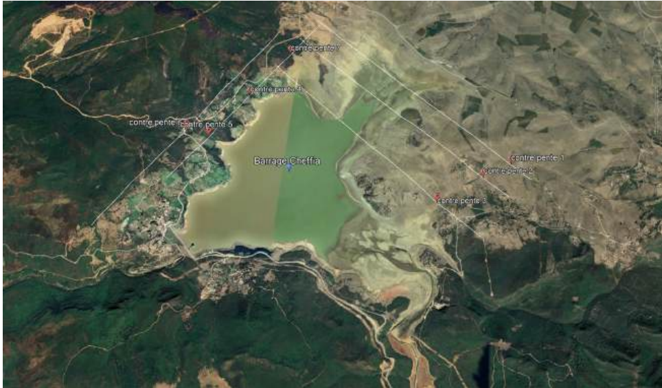
FIGURE 5.11 – Les contre-pentes à proximité du Barrage Cheffia.
