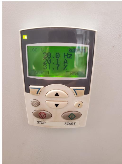
FIGURE 4.15 – Interface du variateur de fréquence
