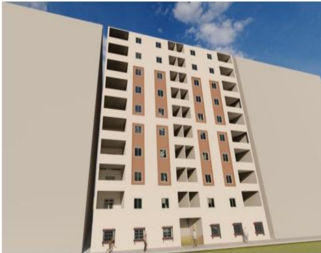
Figure I.1 : Vue de la façade arrière du bâtiment
