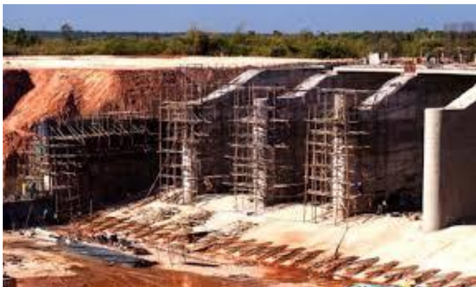
Figure 3 : Site de construction d'un barrage
