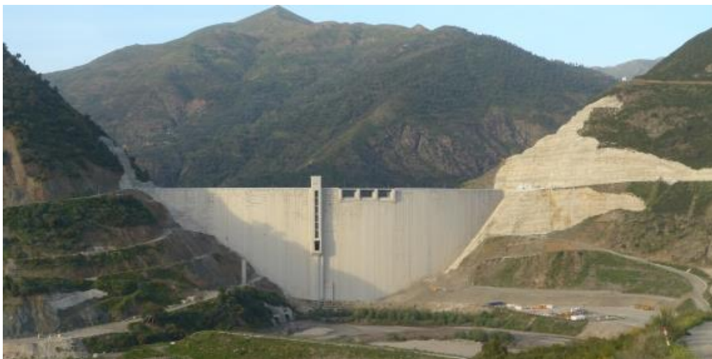
Figure 18 : Barrage de Tabellout à Jijel
