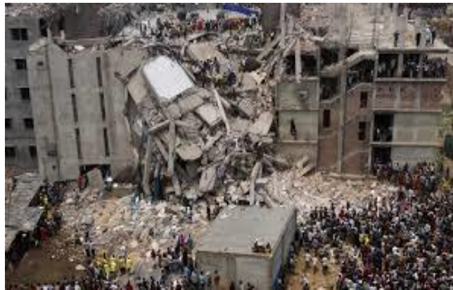
Figure 2.2: Effondrement de la Plaza
