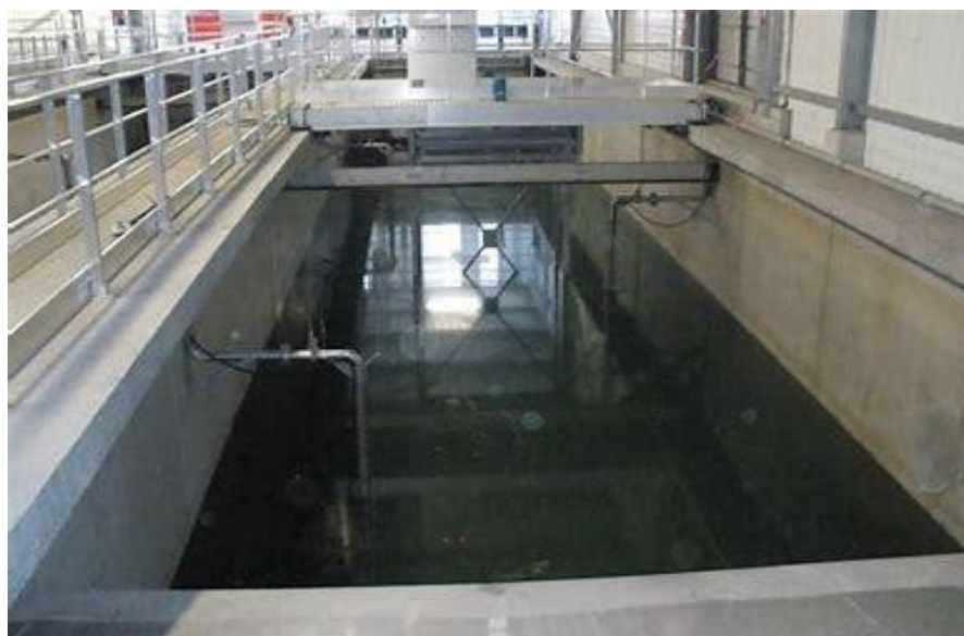
Figure II.4 .Eau usée dans un déshuileur.4.II
