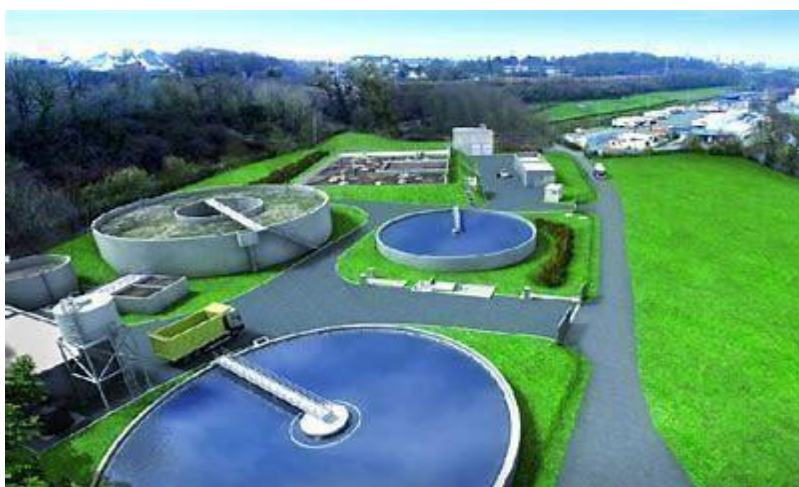
Figure II.1. Vue aérienne d'une station d'épuration
