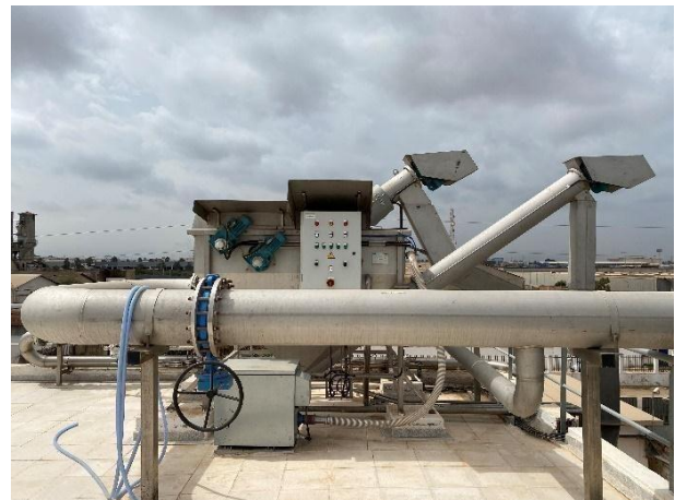
Figure IV.1. Schéma et photo du dégrilleur de la STEP
