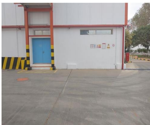
Photo 7 : Sortie de secours menant au chariot élévateur et au camion zone de mouvement dans le quai de chargement/déchargement
