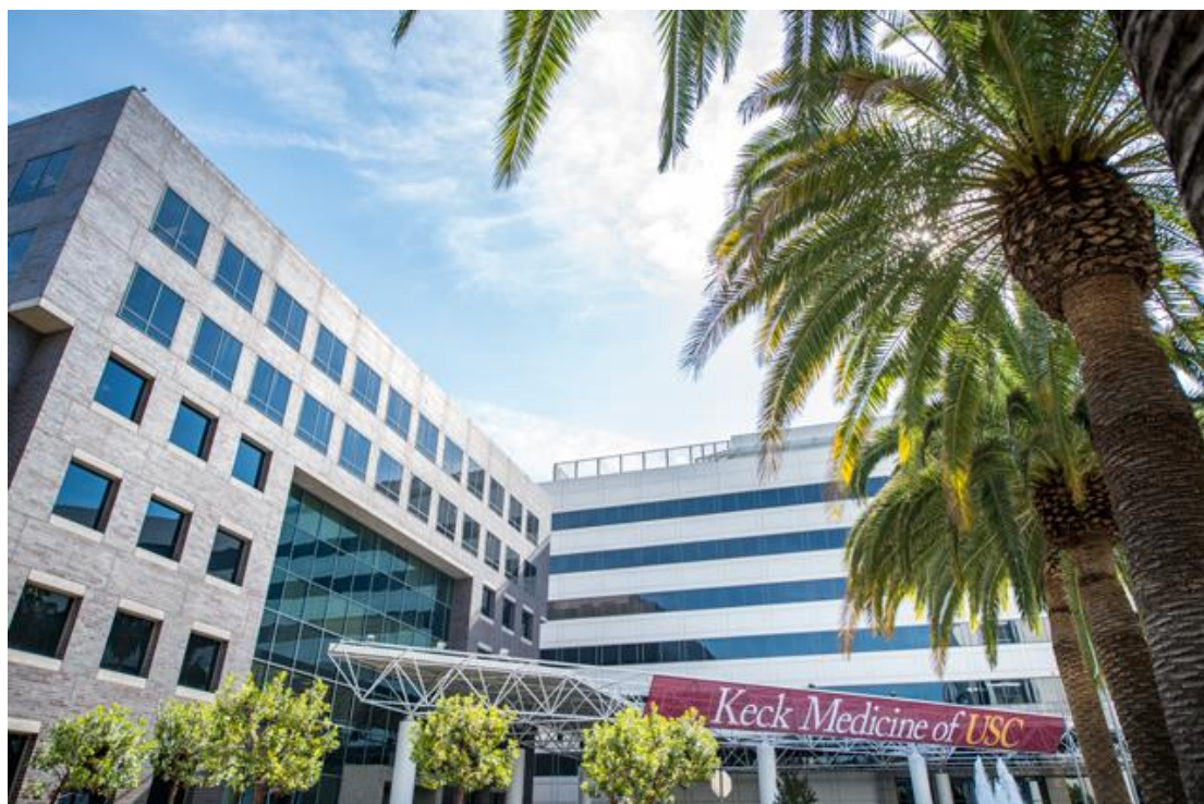
Figure 1.16. Exemple de bâtiments isolés en USA : Hôpital de l'Université de la Californie du Sud protégés par des LRBs
