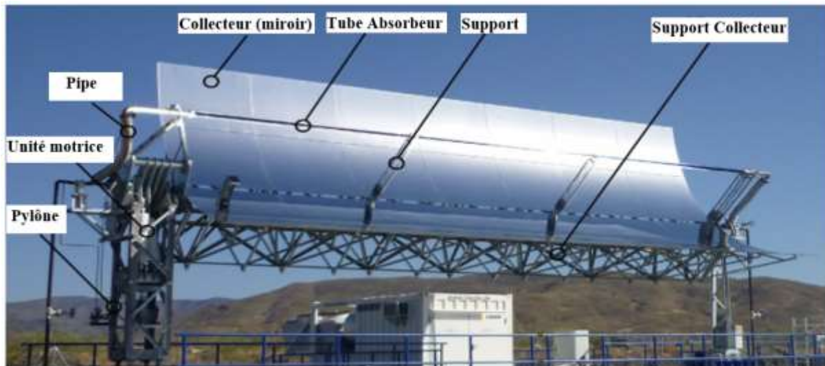
Figure I-11 : Le concentrateur Cylindro-Parabolique
