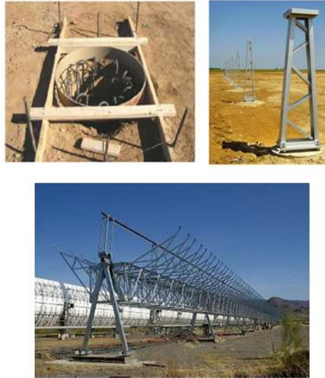
Figure II-14 : Structure de support et collecteur
