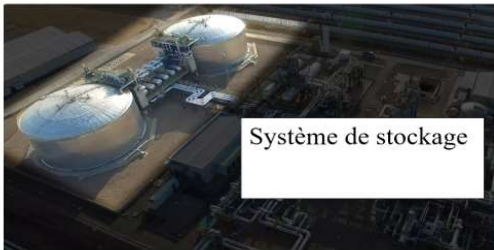
Figure II-17 : Système de stockage à deux réservoirs
