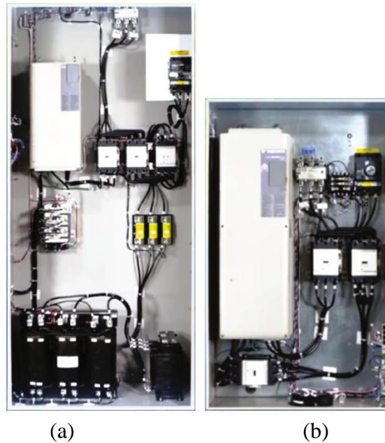
**Figure 1.9.** (a) Convertisseur à base de DC-link (b) Convertisseur matriciel [58]
