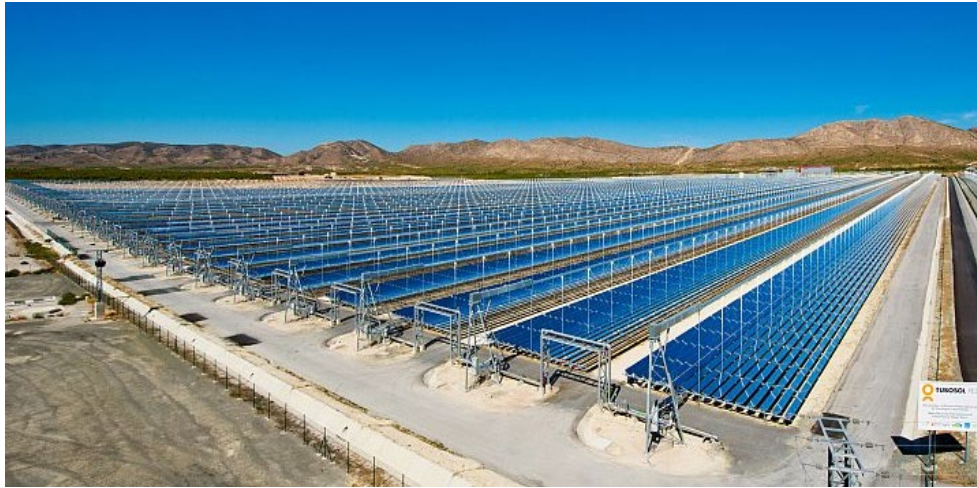
Fig. 1.5 : Exemple d'une centrale solaire à récepteurs de Fresnel [22]
