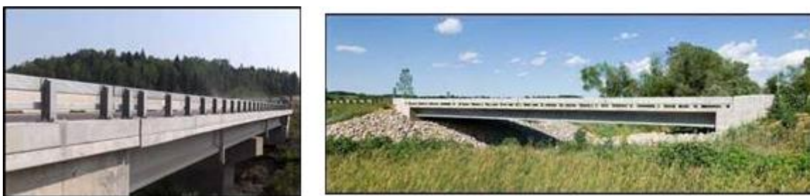
Figure 1.7: Mars Hill Bridge (États-Unis, 2006)
