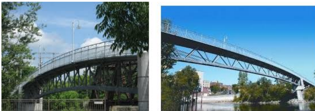
Figure 1.5: Passerelle piétonne de Sherbrooke (Canada, 1997)
