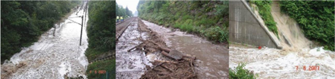
FIGURE 1.1 – Illustrations d'incidents graves : inondation et coulées boues (Ingénierie SNCF Infra).
