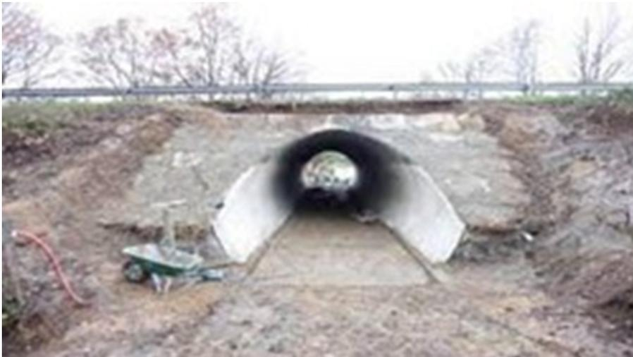
FIGURE 4.7 – Buse en béton ovales [12]
