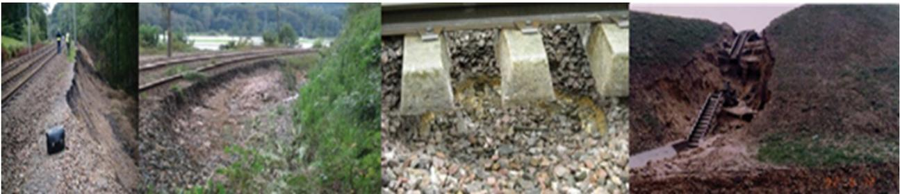
FIGURE 1.2 – Illustrations d'incidents graves : érosions de plateforme, de talus ou de remblais (Ingénierie SNCF Infra).
