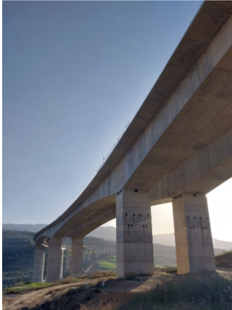
FIGURE 3.2 – Exemple d'un pont construit en encorbellement successif
