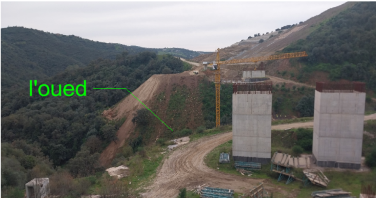
FIGURE 1.1 – Pont en phase de construction et l'oued à franchir (prise le 27-02-2025)
