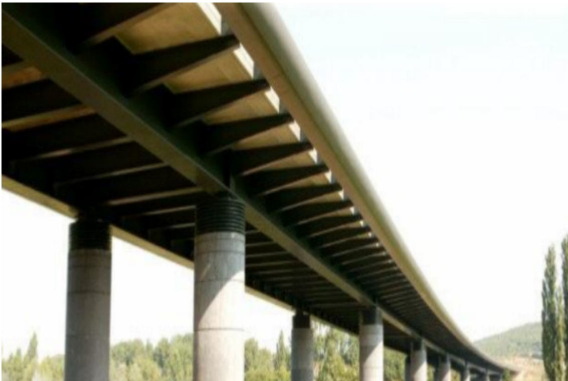
FIGURE 3.1 – Exemple d'un pont mixte acier-beton
