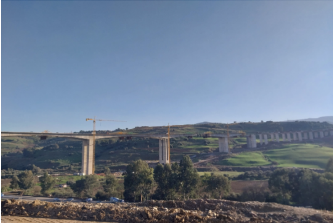
FIGURE 3.4 – Exemple d'un pont mixte (poutres préfabriquées + encorbellement)
