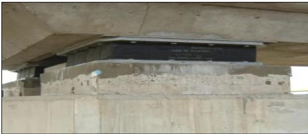
**Figure V.1.Appareil d'appui**
