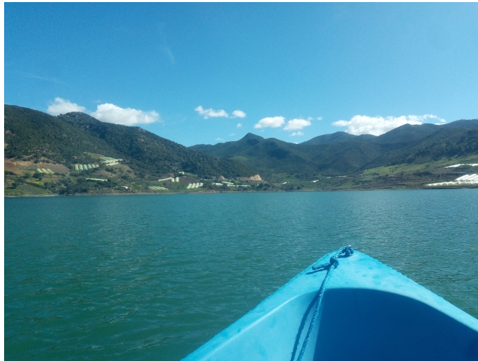
FIGURE 3.2 – Sortie sur site (barrage) le 11-05-2025
