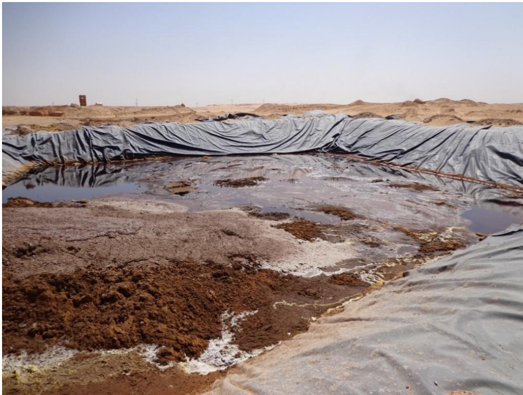
FIGURE 3.1 – Zone de stockage des déblais de forage (bourbier)
