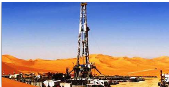
(a) Plateforme pétrolière Onshore [5]
