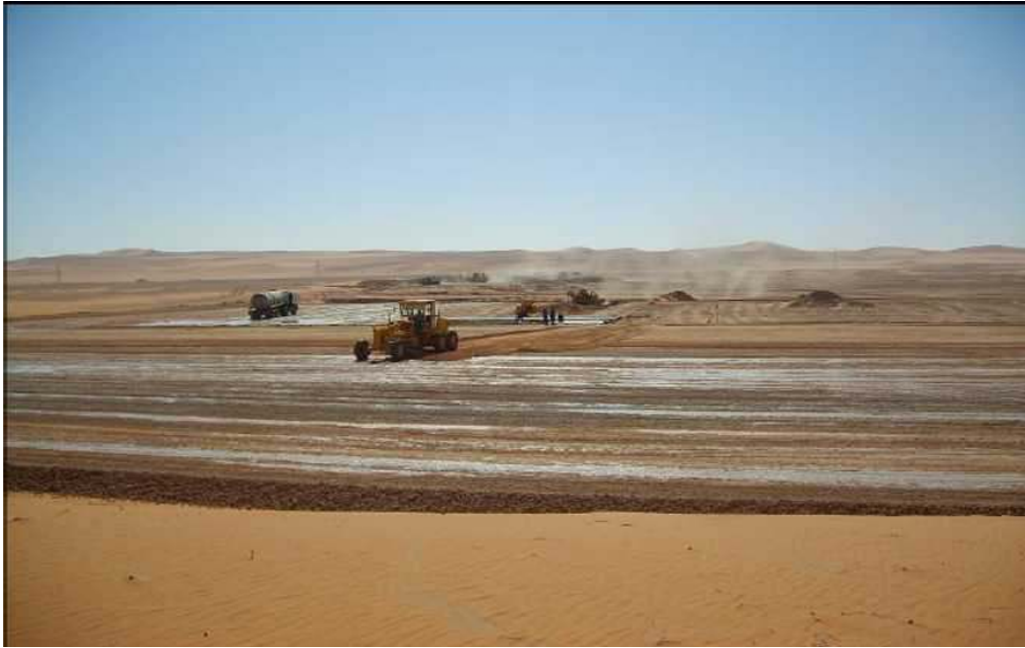
FIGURE 3.4 – Préparation du terrain
