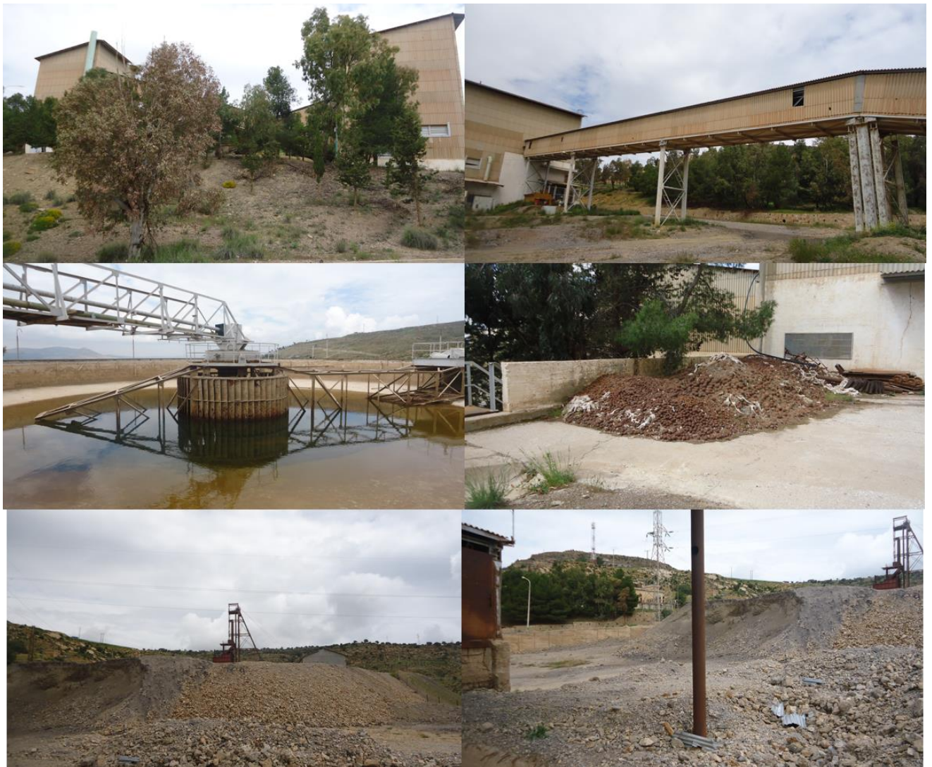
Figure 1.2.3: Etat des lieux à la mine d'El Abed (Mai, 2018).
