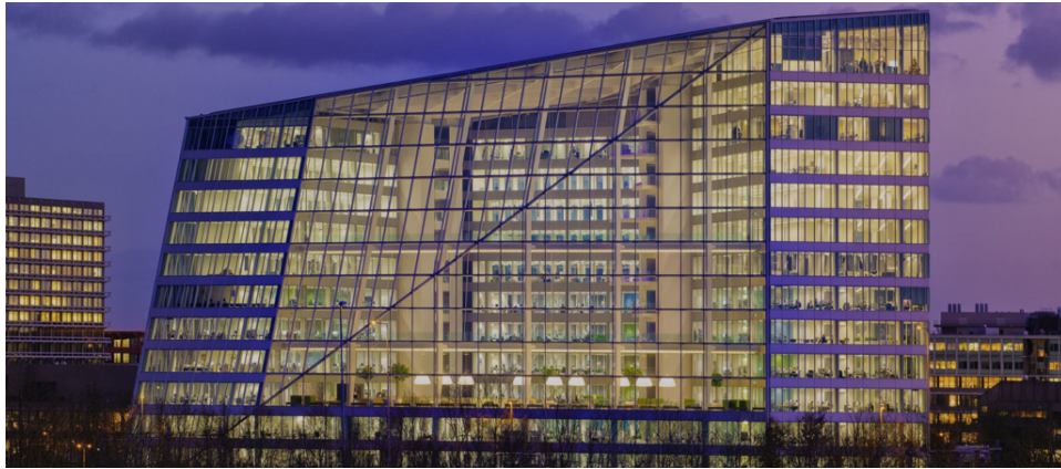
FIGURE 1.22 – Façade du bâtiment The Edge [154].
