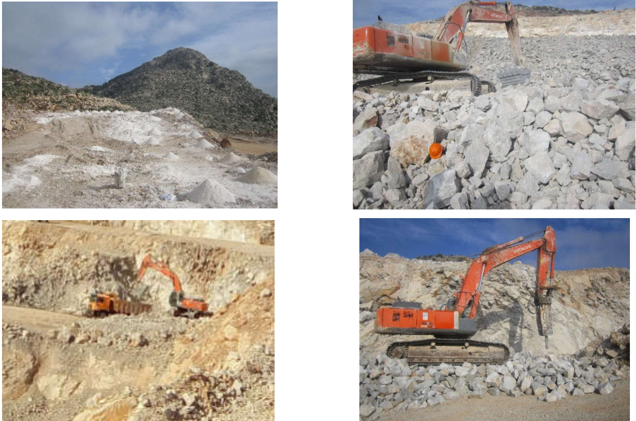
Figure 3.11: Différents travaux miniers au niveau de la carrière de Djebel Bouzegza (foration, chargement, transport, fragmentation secondaire).
