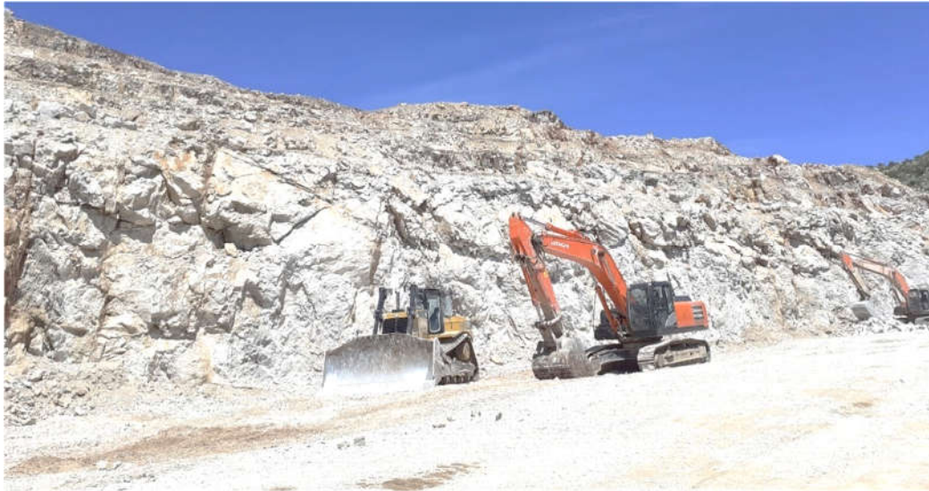
Figure 3.8: Le réseau des fissures sur le front de taille au niveau de la carrière de Djebel Bouzegza
