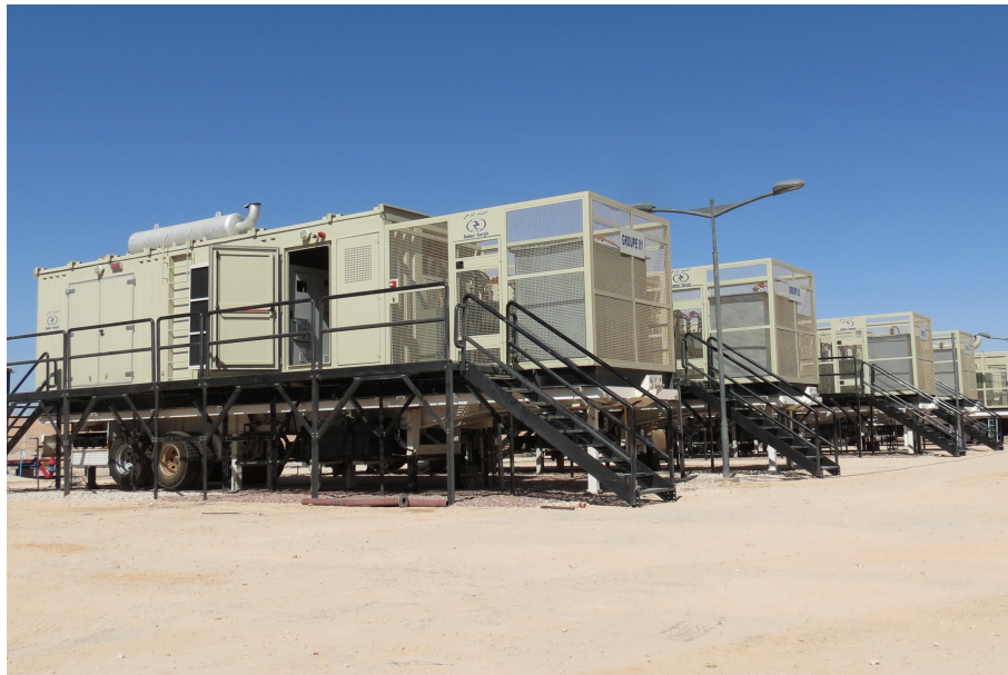
Figure 2: Centrale diesel mobile d'AMIMER ENERGIE au Sahara
