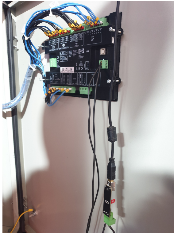
Figure 59: Câblage de la carte SGC 420 avec le PC via un convertisseur USB/RS485
